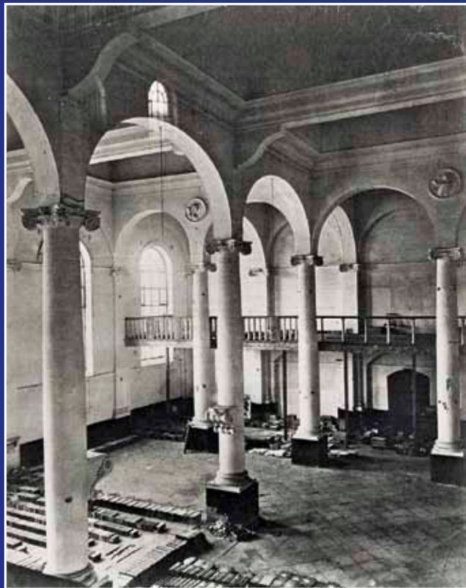
Interni della Hofkapel intorno al 1878
