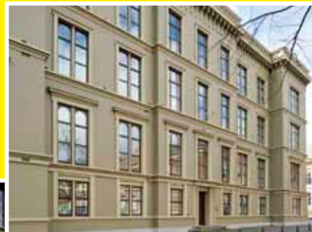
Ehemaliges Kolonial- ministerium
